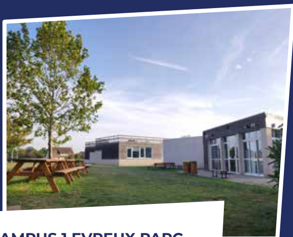
CAMPUS 1 EVREUX PARC Parc d'activités de la forêt 461 rue Henri Becquerel 27000 Evreux
